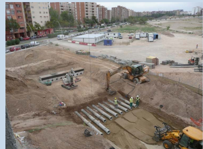
Colocación tubos canadienses diferentes fases
