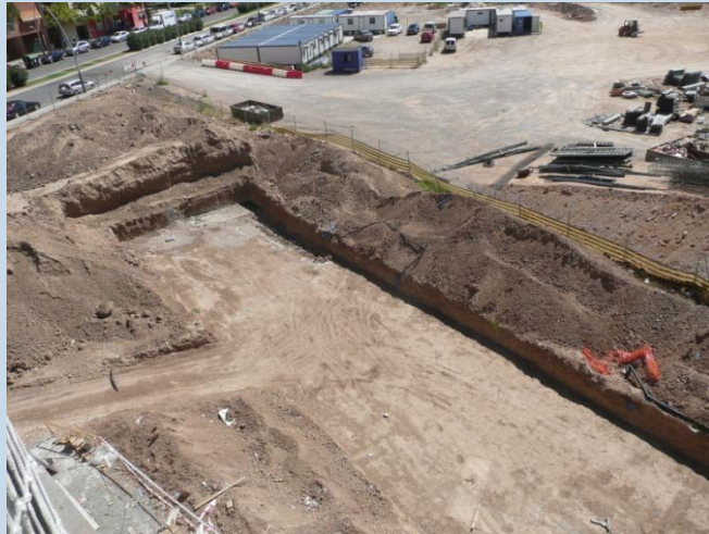
Excavación para alojar tubos canadienses
