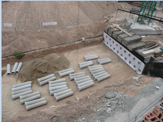
Colocación tubos canadienses diferentes fases
