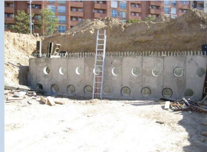
Colector enterrado, entrada de tubos
